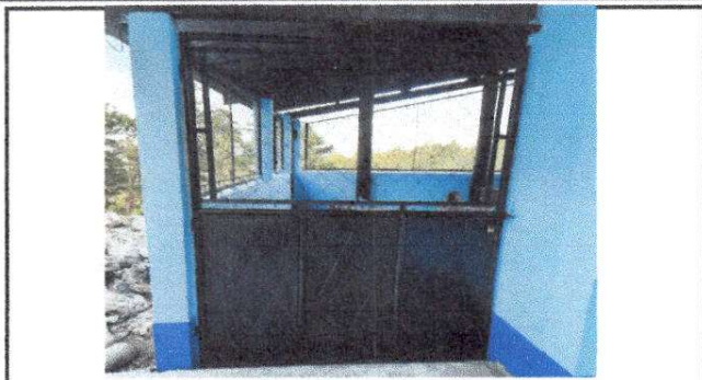
Foto 1: Mantenimiento de estructura: lijado y aplicación de pintura en puerta de metal del módulo 2 cocina
