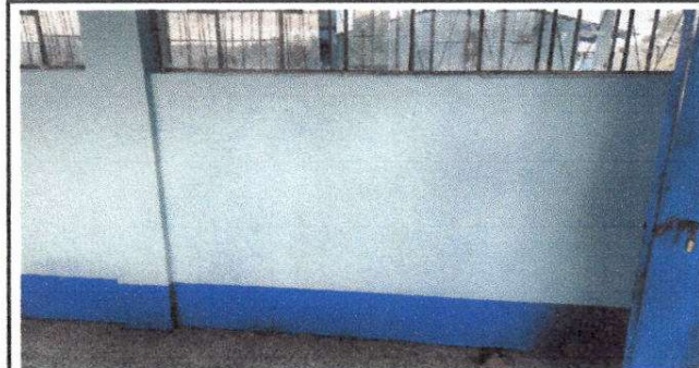
Foto 16: Pintura en muros interiores del modulo 1
