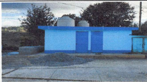
Foto13: Pintura en muros exteriores
